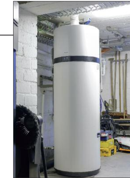
Der Daikin Altherma M HW 260 liefert Warmwasser bis 62 °C auch bei niedrigen Umgebungstemperaturen.
