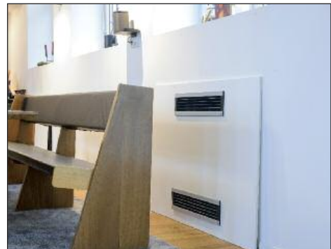
Über die Luftauslässe im Wohnbereich unterstützt die VRV 5 Anlage die Fußbodenheizung und übernimmt die zusätzliche Heizlast.
