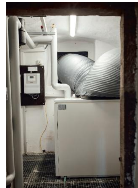
Die WPL 24 I mit einer Heizleistung von 12 kW passt perfekt in den unteren Chorraum der ehemaligen Burkapelle. Luftansaugung und -auslass werden unauffällig über bestehende Öffnungen sichergestellt: ein vergittertes Fenster und einen alten Abortschacht.
