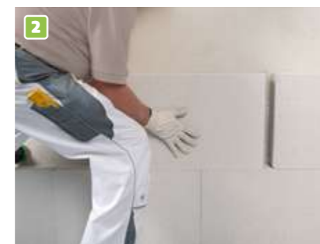
2 Vollflächig mit FIX X710 im Verbund verklebte Dämmplatten
