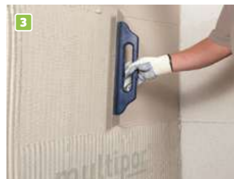
3 Armierung mit Leichtmörtel FIX X710
