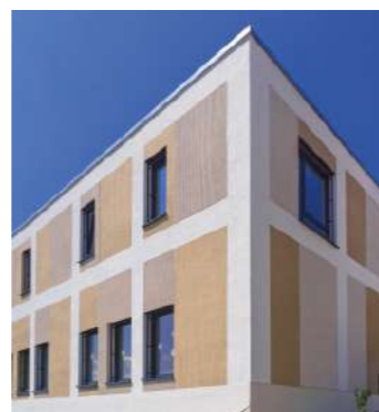
Der Wechsel von helleren, glatten Putzfeldern mit farblich abgesetzten Flächen in Kammzug und Besenstrich verleiht der Fassade einen einzigartigen Charakter.
