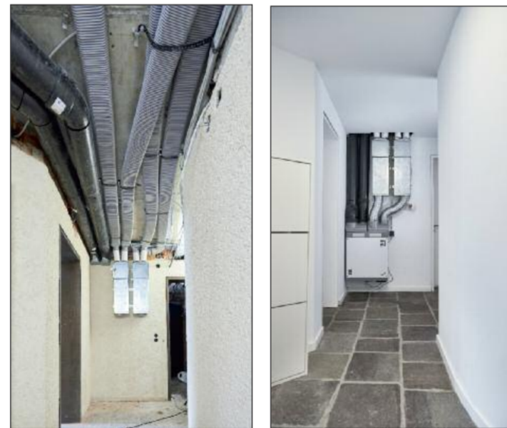
Das kompakte Komfort-Lüftungsgerät Zehnder ComfoAir 180 passte perfekt in eine ungenutzte Ecke der Einliegerwohnung. Im Alltag nehmen die Bewohner neben dem stylischen Luftauslass davon nur das Frischluftgefühl im ganzen Haus wahr.
