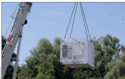
Bedürfnisse angepasst werden. Eine Energy Unit kann - soweit sie ausschließlich Wärmepumpen und keine Gasheizgeräte enthält - unter Beachtung der gängigen Vorschriften in der Regel genehmigungsfrei und flexibel platziert werden. Eine Energy Unit wird serienmäßig vorgefertigt, betriebsfertig geliefert, vorab geprüft und aufgestellt. Die Fertigung findet zudem unabhängig von der Witterung in einer Werkshalle statt. Das
