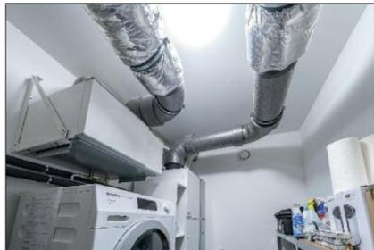
Alles drin: NIBE Abluft-Wärmepumpen vereinen Heizung, Warmwasserbereitung und Wohnungslüftung in einem Kompaktgerät.
